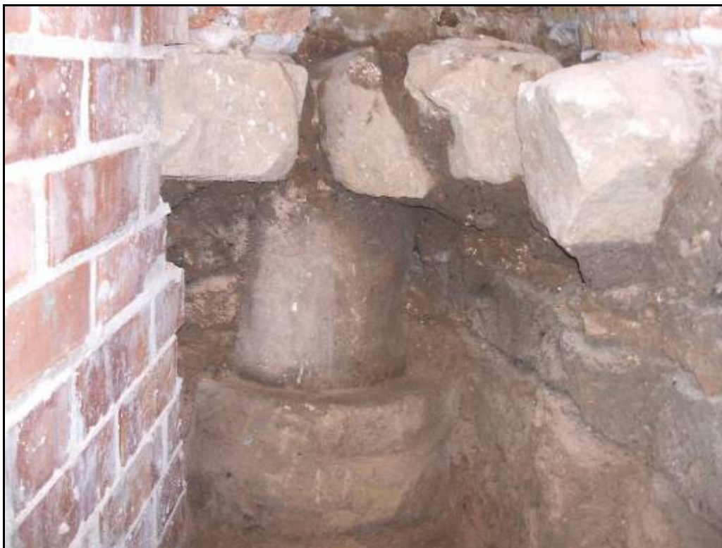
Fotografia 47: Pedres UE 313, damunt la columna UE 319.
