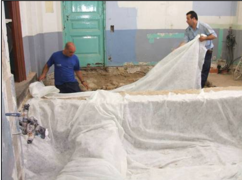
Fotografia 20: Cobriment amb geotèxtil de les estructures.
