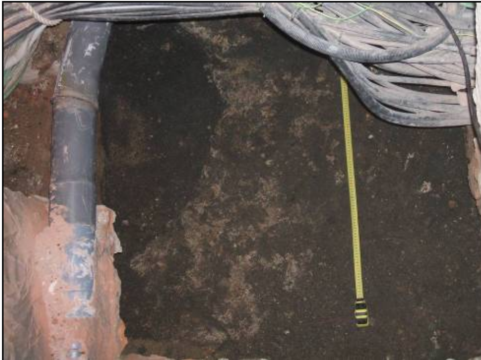
Fotografia 51: Pou, parcialment trencat, UE 314.
