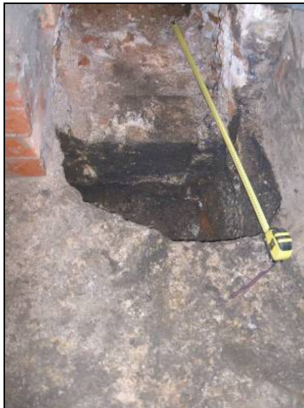
Fotografia 52: Pou UE 314, rebaixat parcialment.
