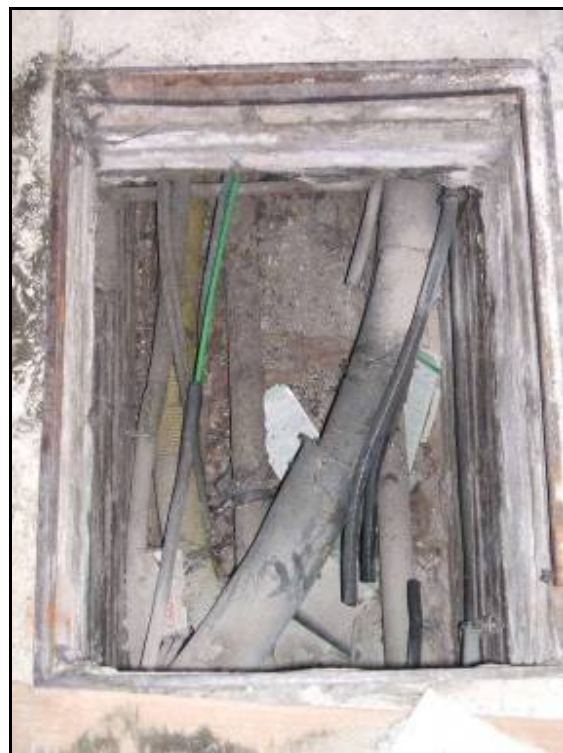
Fotografia 4: Arqueta de la canalització de cablejat elèctric (UE 102).
