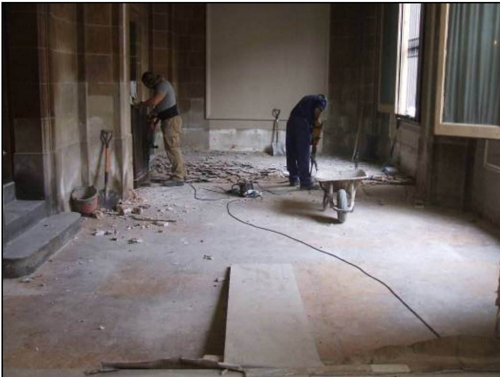
Fotografia 22: Sector 2 (Majordomia). Aixecament del paviment.
